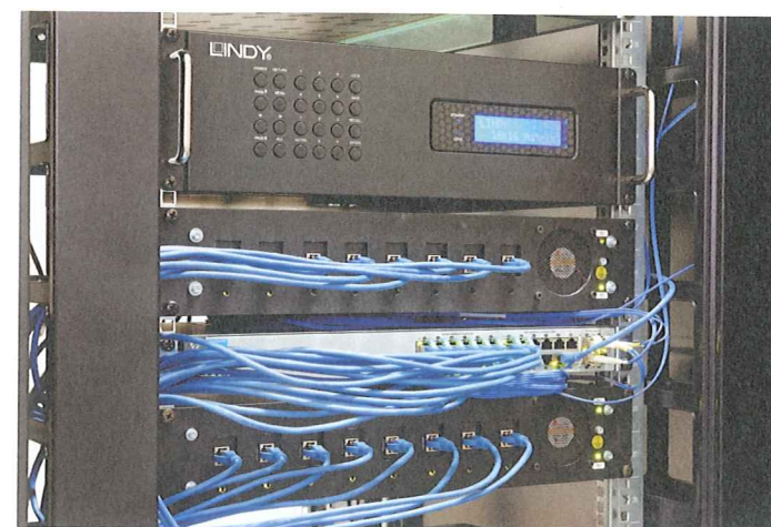
Als Besonderheit sind die unmittelbar vor und hinter der Lindy-Matrix zum Einsatz kommenden Lindy Extendermodule in zwei 19"-Rahmen untergebracht.
